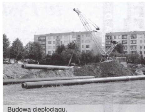
Budowa ciepłociągu.
