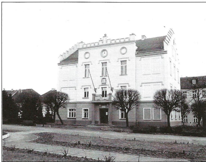
Ratusz z nową elewacją
