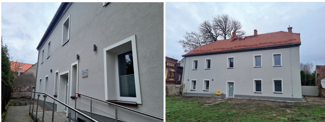
Fot. 24. Budynek ORPU po termomodernizacji
