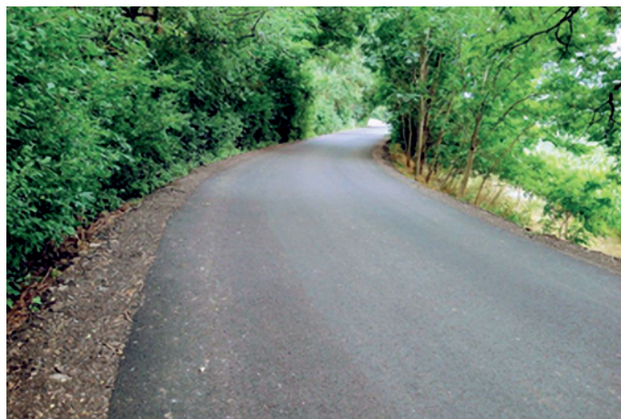
Fot. 10. Przebudowa ul. Młyńskiej w Pyskowicach
