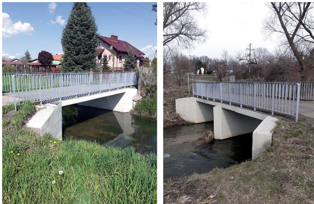
Fot. 15. Od lewej: Most przy ul. Magazynowej i przy ul. Zaolszany po remontach wykonanych w 2022 r.
