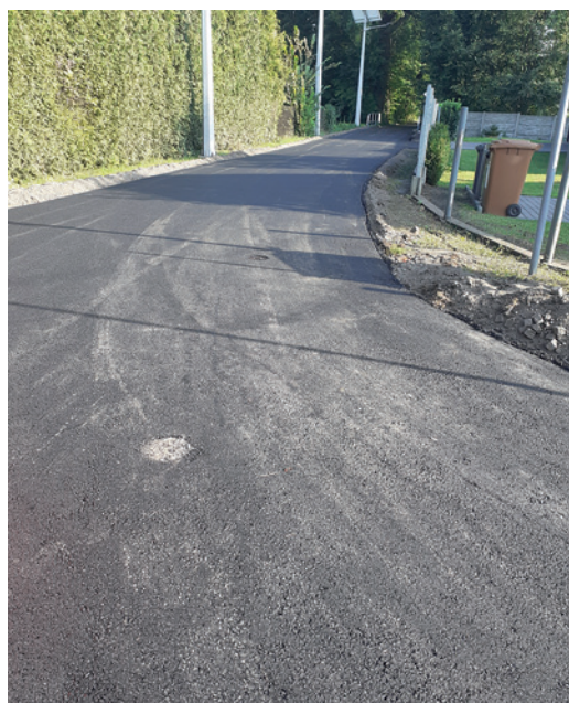
Fot. 16. Przebudowana w 2022 r. ul. Żuźłowa
