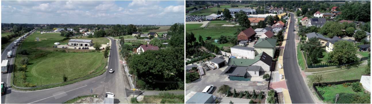
Fot. 9. Przebudowana ul. Kard Stefana Wyszyńskiego na odcinku od skrzyżowania z ul. Wyzwolenia do połączenia z ul. Bytomską (DK-94)
