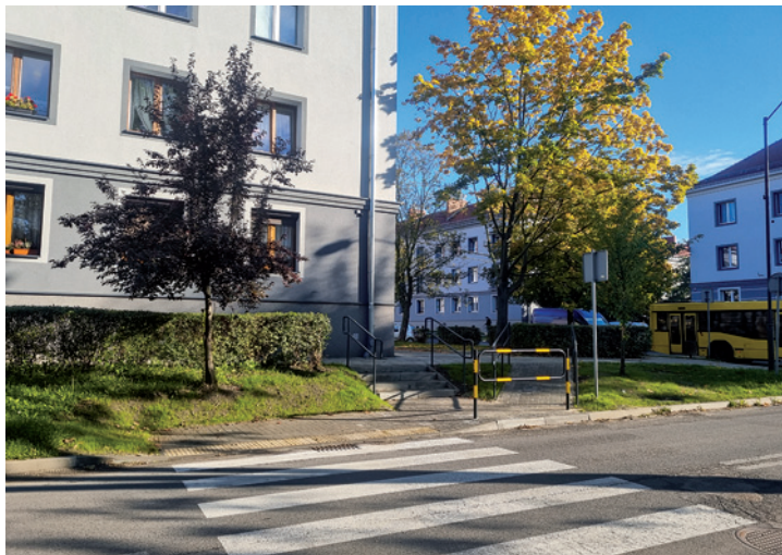
Fot. 11. Przebudowa chodnika wraz ze schodkami przy ul. Strzelców Bytomskich 8 źródło: archiwum Urzędu Miejskiego w Pyskowicach
