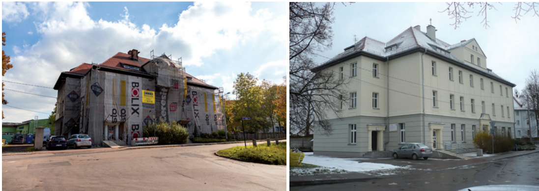
Fot. 23. Budynek przy ul. Sikorskiego 83 w trakcie i po termomodernizacji
