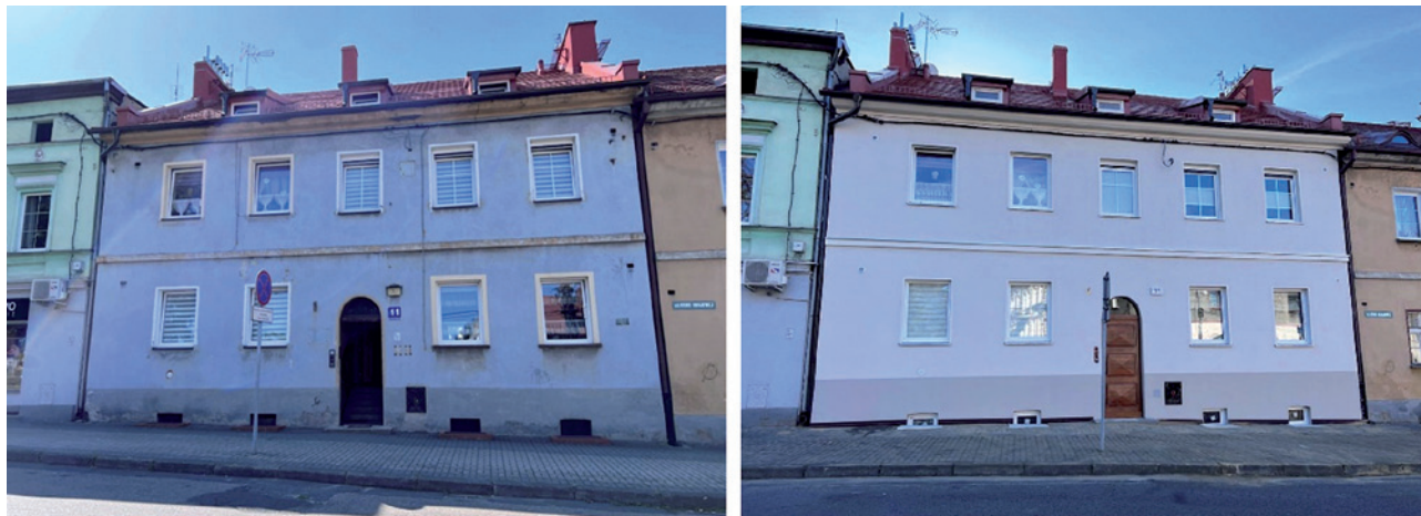
Fot. 21. Budynek przy ul. Armii Krajowej 11 w Pyskowicach przed i po modernizacji
